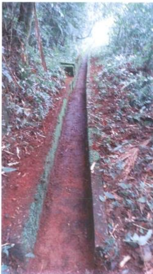
Foto 2 – Limpeza da canaleta – Manutenção Preventiva
