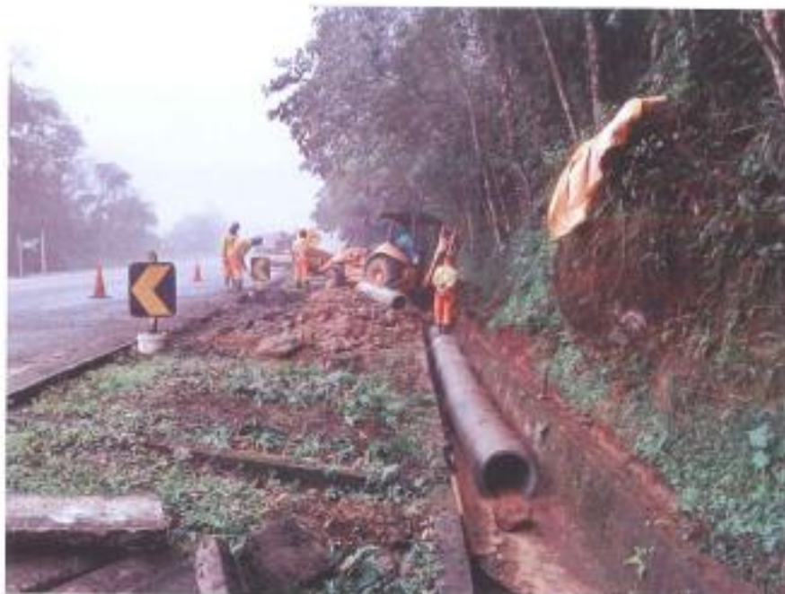
Foto 3 – Implantação de área de refúgio – Km 62,6 [1]
