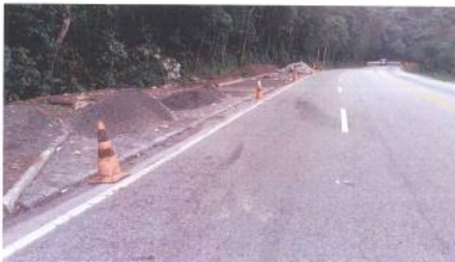
Foto 4 – Implantação de área de refúgio – Km 62,6 [2]
