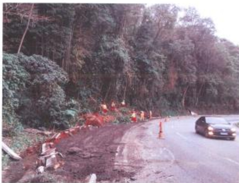
Foto 5 – Implantação de área de refúgio – Km 54,1 [1]
