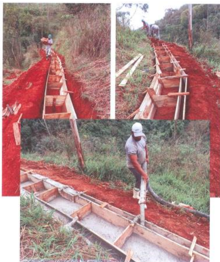
Foto 9 – Ampliação do sistema de drenagem – Km 132,5
