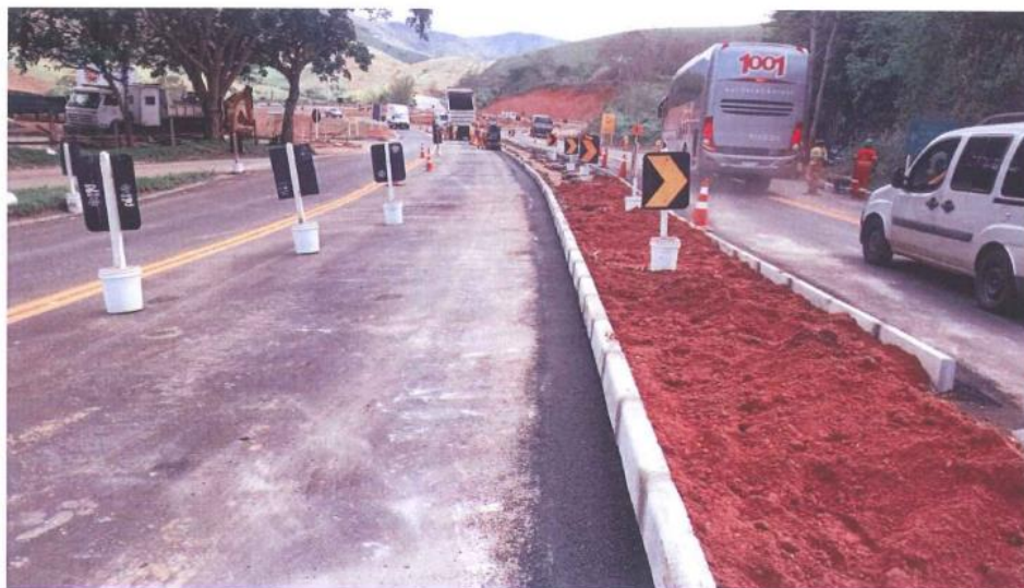
Foto 8 – Adequação da Interseção Cordeiro A - 123+300 [2]
