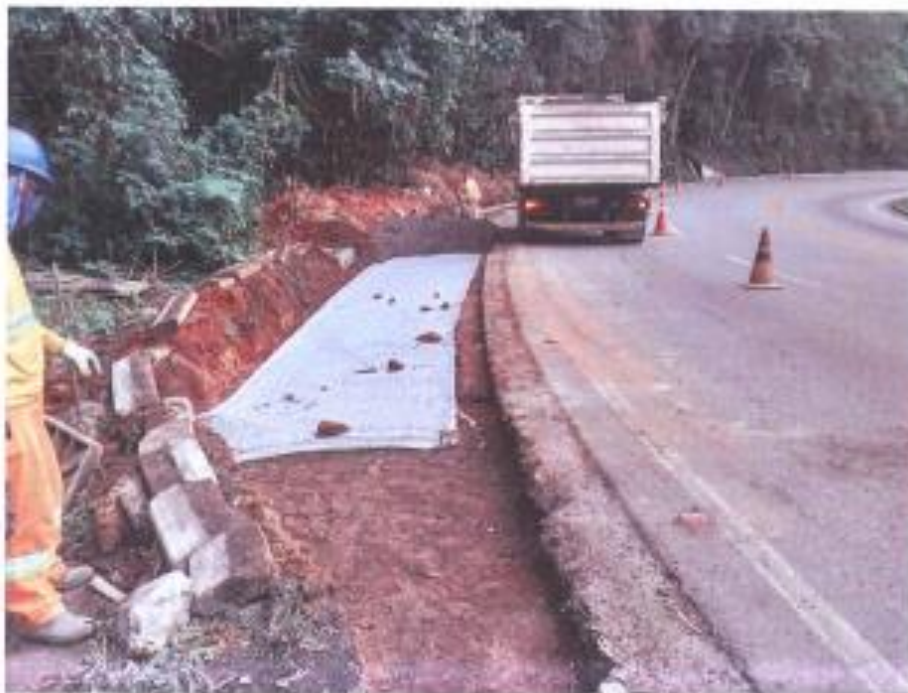
Foto 6 – Implantação de área de refúgio – Km 54,1 [2]
