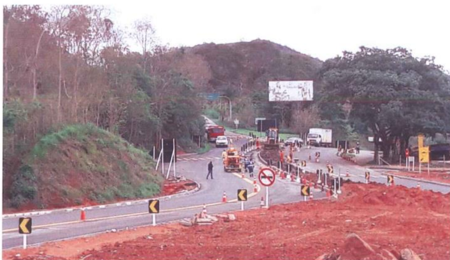
Foto 7 – Adequação da Interseção Cordeiro A - 123+300 [1]
